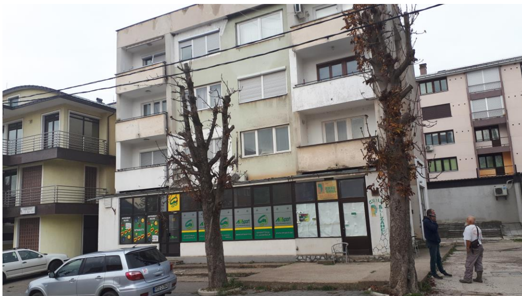
Slika br. 4.: Stambeno poslovni višeporodični objekat građen prije devedestih godina (izvor: Nosioc izrade, novembar 2019. godine)
