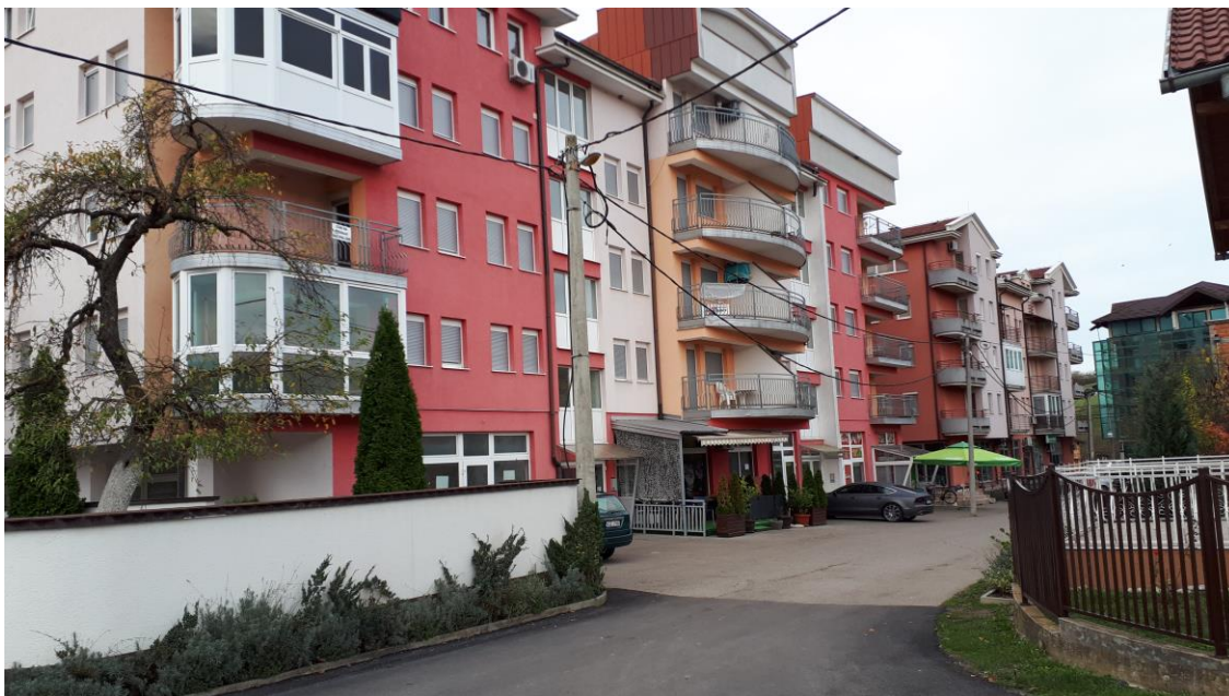
Slika br. 5.: Stambeno poslovni višeporodični objekat građen poslije posljednjeg rata (izvor: Nosioc izrade, novembar 2019. godine)
