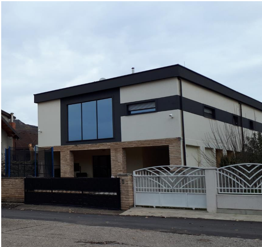
Slika br. 7.: Objekat individualnog stanovanja građen poslije devedesetih godina prošlog vijeka („urbana vila“ forma individualnog stanovanja) (izvor: Nosioc izrade, novembar 2019. godine)
